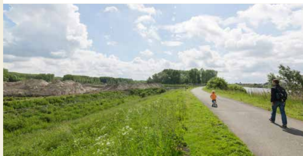
De zandopslag met zand uit de Durme
