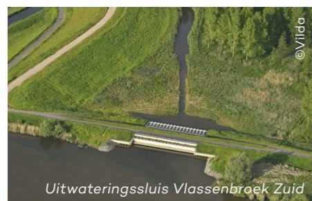
In- en uitwateringssluis Vlassenbroek Noord
